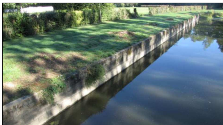
Figure 14 : Muret en béton situé en rive droite en amont de la passerelle du plan d'eau
