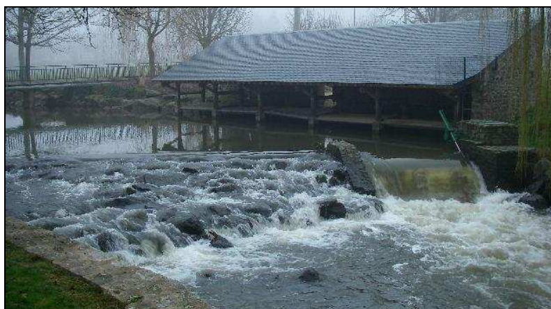
Figure 10 : Barrage - Clapet du Gué des Barres
