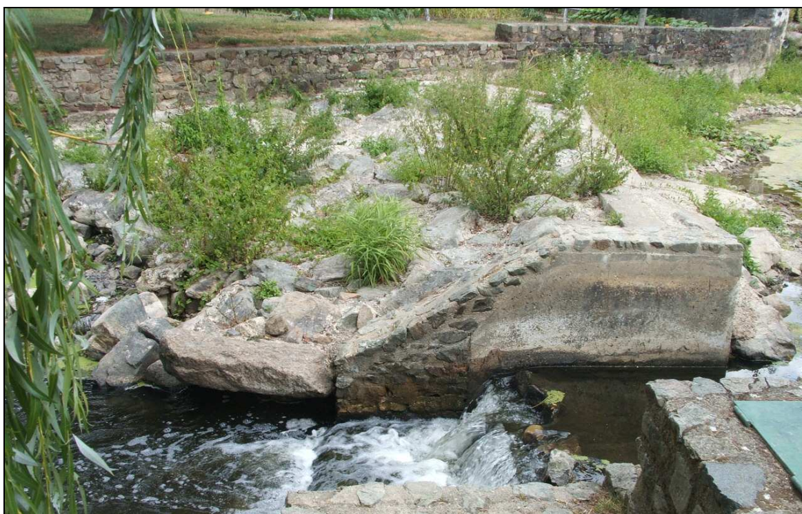
Figure 24 : Photographie du clapet du Gué des Barres
