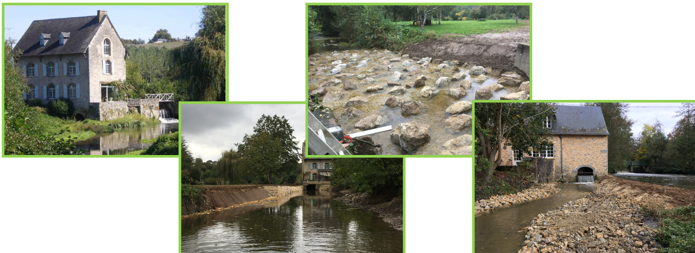
Travaux connexes à Montguyon
