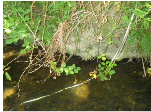
Présence d'une sous-berge
