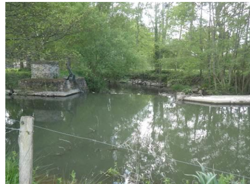
Vue amont ouvrage 2017
