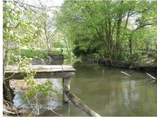
Vue amont ouvrage 2017
